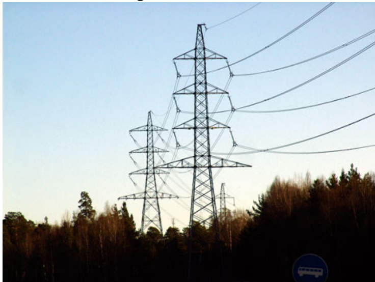
Dubbel 200 kV ledning
